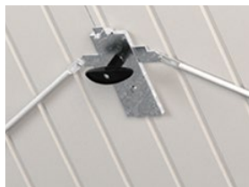
Zamek z wkładką ryglującą bramę dwustronnie
